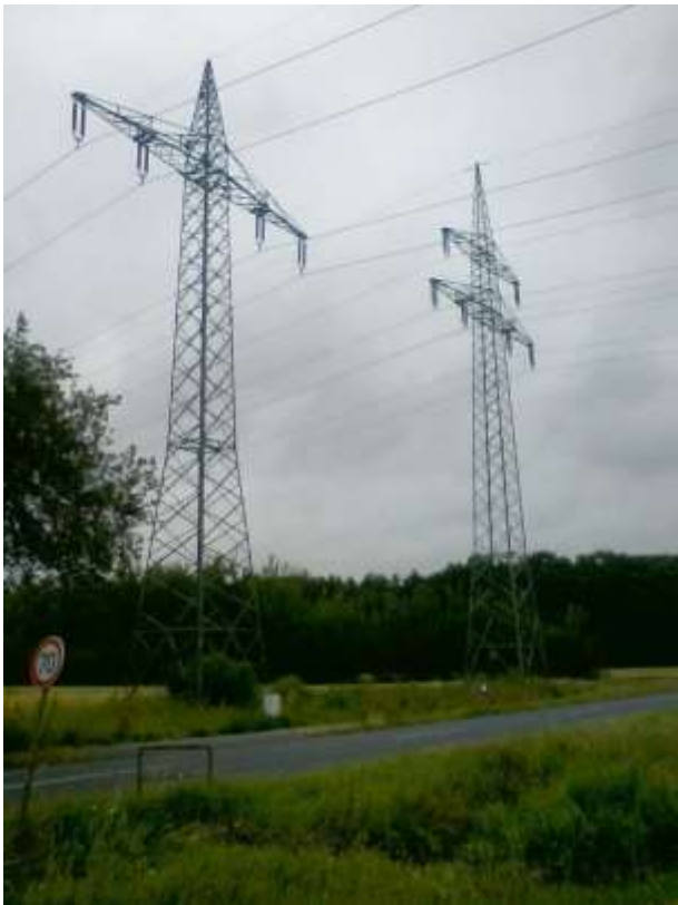
Bild 2-2: 110 kV Freileitungen über der Scharnebecker Straße (vorne DB dahinter Avacon) und über der Bebauungsfläche
